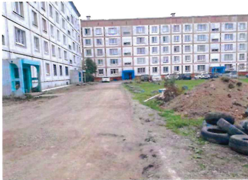
Начало благоустройства дворовой территории Северного городка, 39, 39а
