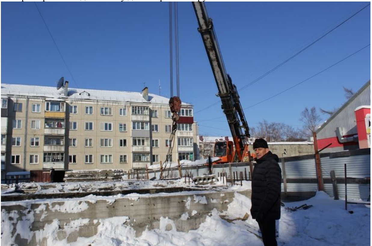
Контроль работ по демонтажу долгостроя на округе
